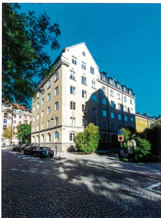
Vår fastighet Ryttaren 9
